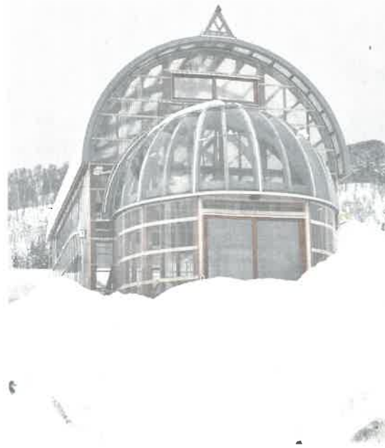
木造農業用ハウス。屋根の上に見えるのが雪割り
