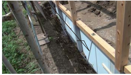
断熱材で地熱を遮断する
