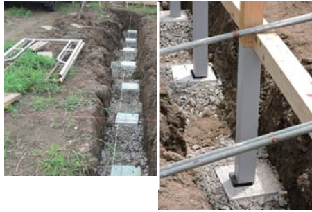
柱足元パッキンで高さ調整 埋め込み部分は900防水加工
