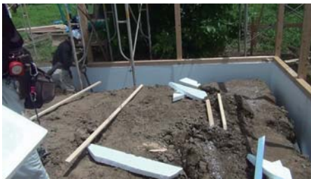
土台外側に断熱材取り付け
