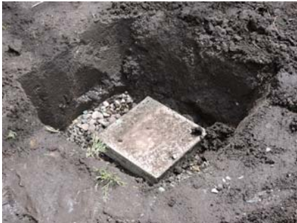
砕石敷き込みコンクリート板敷き
