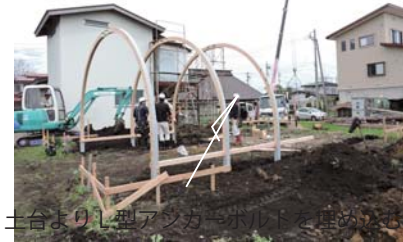
土台よりL型アスカーボルトを埋め込む
