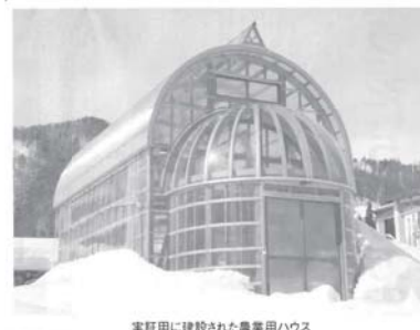
実際に建設された農業用ハウス
