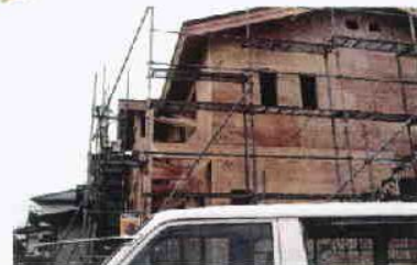
建て方より7日目
